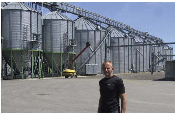
Siloanlægget der bruges til indtagning af raps for DLF, samt naturligvis korn for Agro-Alliancen
